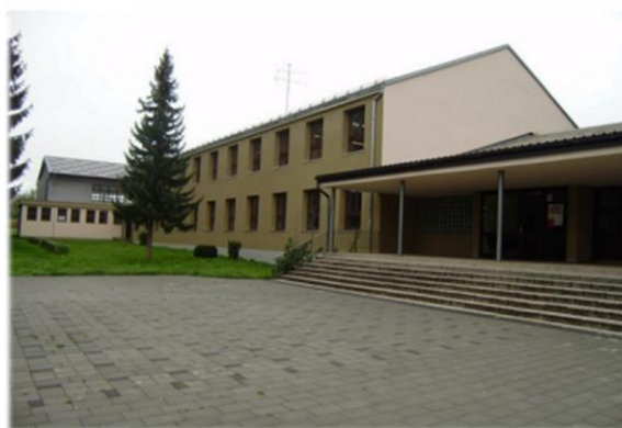
Slika 12. Zgrada Osnovne škole „Josipdol”
